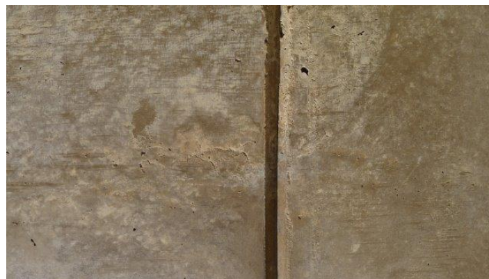
Fig. 2_ parements des voiles de béton de terre coulée _ chantier CTE ouest à Fontaine (38)
