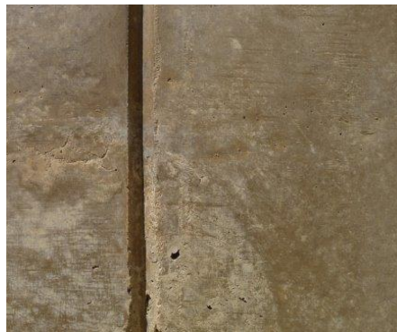
Fig. 7 & Fig. 08_ Coulage des voiles de béton de terre coulée _ chantier CTE ouest à Fontaine (38)
