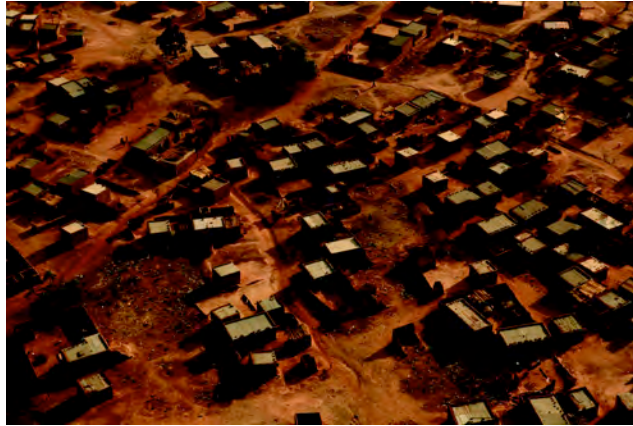
Fig. 2. Vue aérienne d'un quartier populaire et de ses toitures en tôles. Burkina Faso
